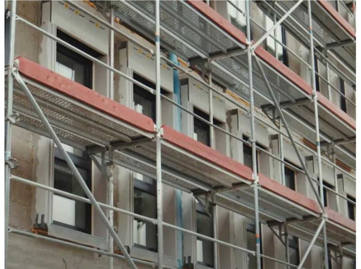
WDVS-SYSTEMZARGE für WDVS-Neubau/Altbau und modernen Holzbau.
