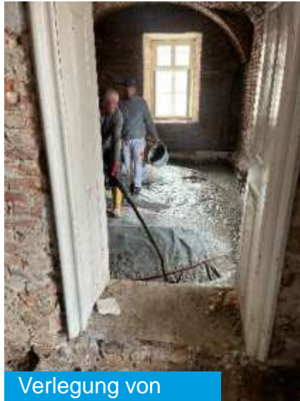
Auf Trennlage im Stehen leicht verarbeiten
